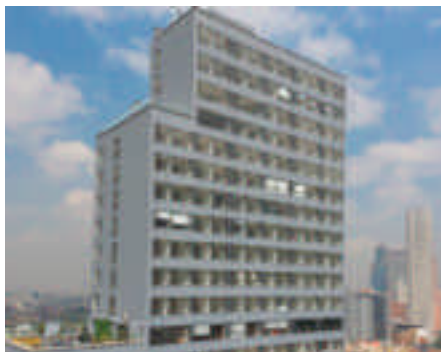
TORRE BARCELONA, BOGOTÁ ARQUITECTO: HMA CONSTRUCTOR: GRUPO SOLERIUM S.A.
