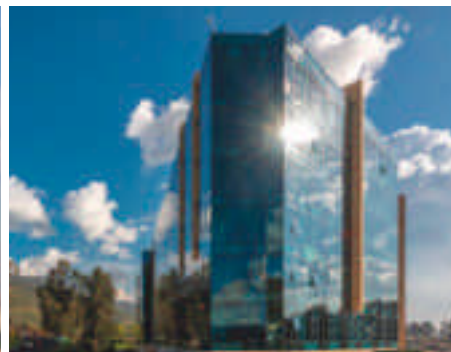
SIBELIUS EMPRESARIAL, CHÍA ARQUITECTO: HERNANDO HEREDIA CONSTRUCTOR: HERNANDO HEREDIA
